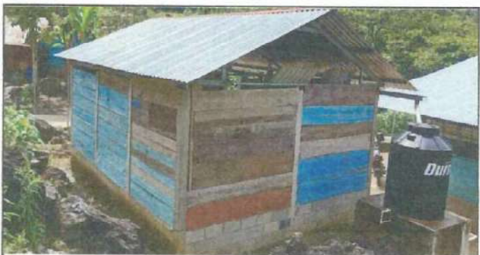
Foto 3: Mejoramiento de cisterna pluvial
