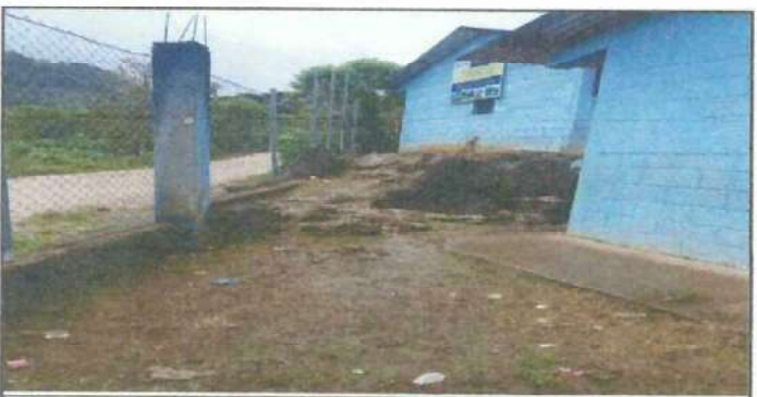
Foto 5: Reforzamiento de muro perimetral de malla galvanizada.
