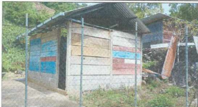
Foto1: Mejoramiento de modulo Existente con Muro de Mamposteria
