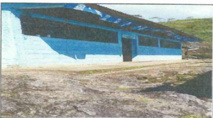
Foto 4: Mejoramiento de pisos de concreto
